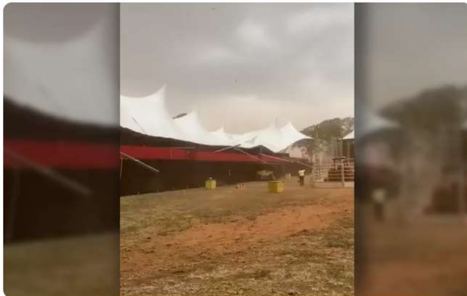
Estrutura da EXAPIT em Tupã (SP) é comprometida por tempestade de vento — Foto: Arquivo Pessoal
