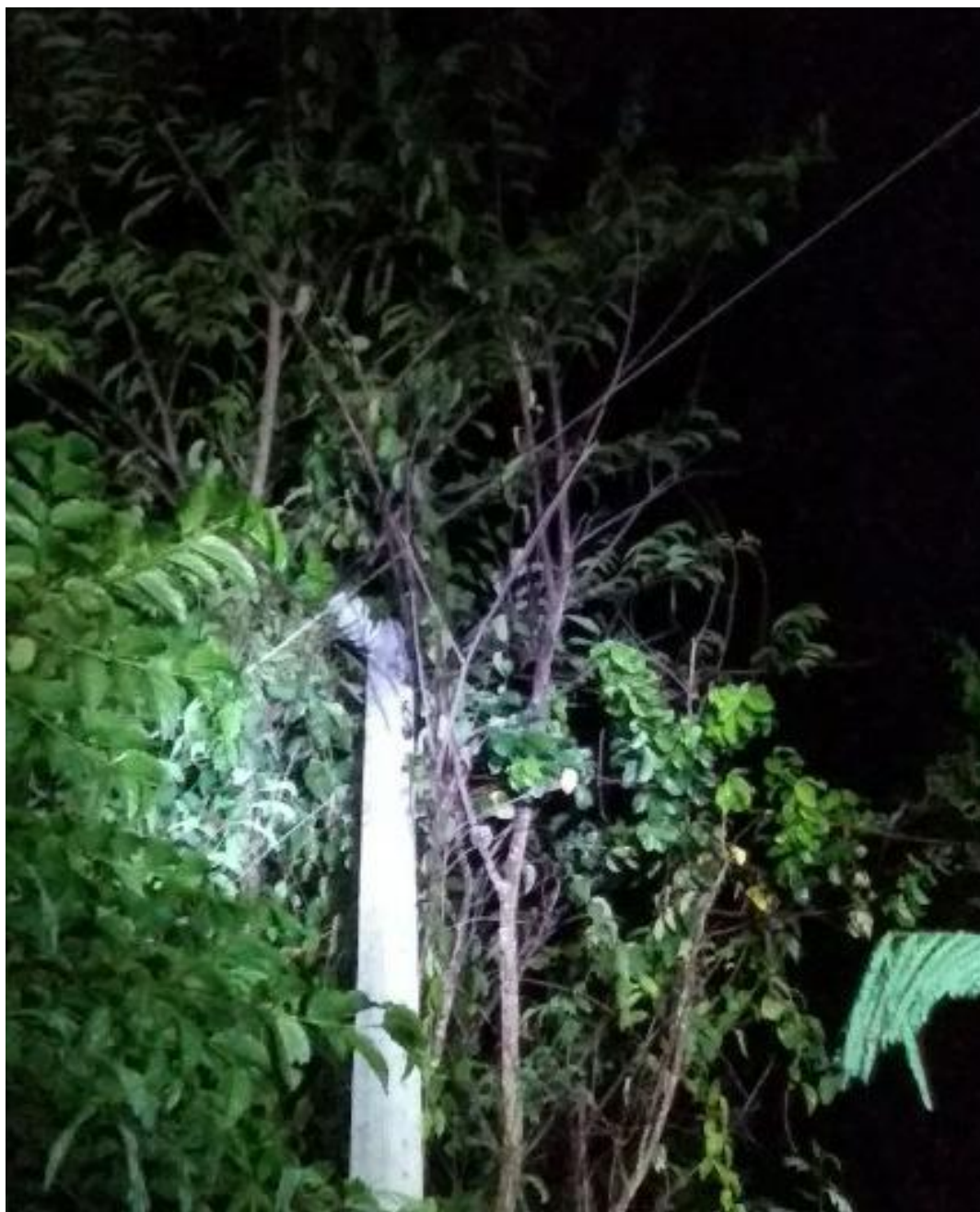
Figura 81 - Registro feito em Alta Floresta de uma árvore na rede. Foto tirada em 31/10/2022 - OS 20223663297394
