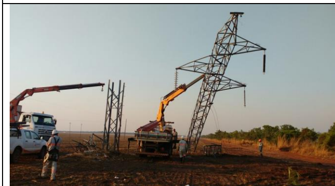
Foto 07 - Equipe em atendimento no local
