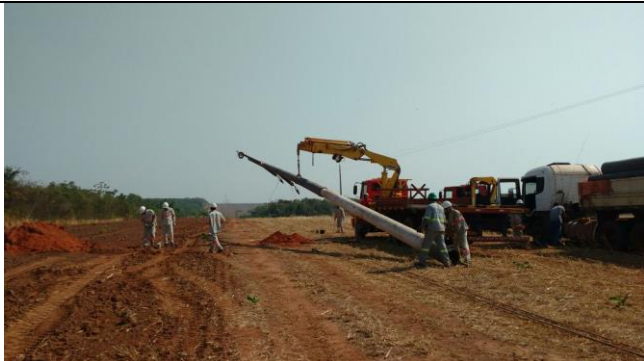
Foto 09 - Equipe em atendimento no local
