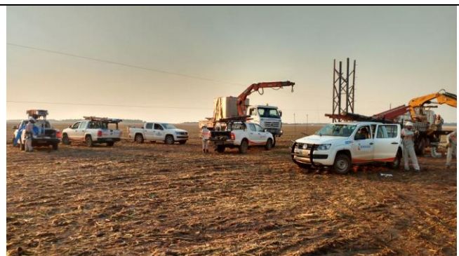
Foto 08 - Equipe em atendimento no local
