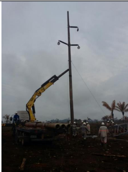
Foto 11 - Equipe em atendimento no local
