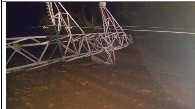
Foto 05 - Estrutura Danificada
