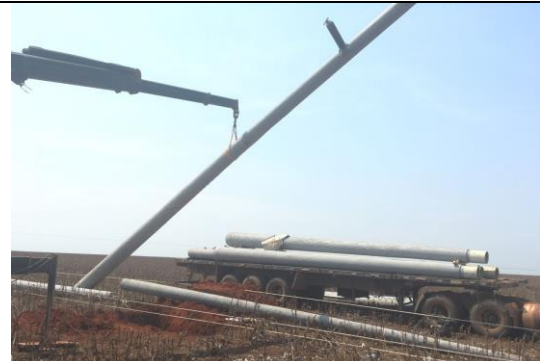
Foto 10 - Equipe em atendimento no local
