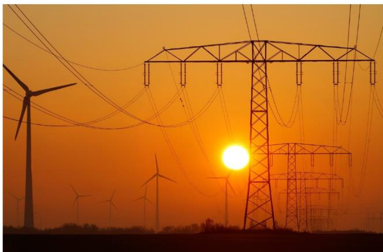
Transformadores não têm suportado os picos de carga causados pelo clima severo
