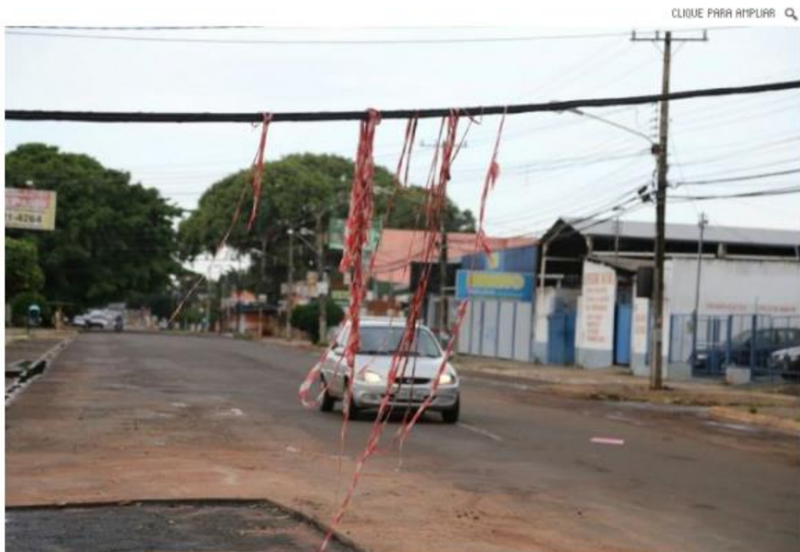
Fio rompido atravessa avenida Bandeirantes. (Foto: Marcos Ermínio)
