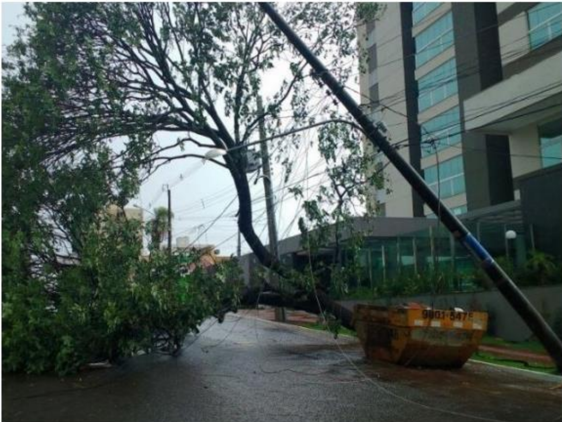
Poste de energia elétrica ficou pendurado após queda de árvore de grande porte na Rua Arthur Jorge (Foto: André Bittar)
