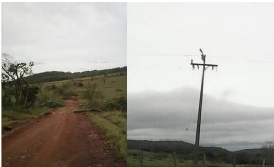
Fonte: Fotos Colaborador ENERGISA MS – Bodoquena – 01/10/2017
