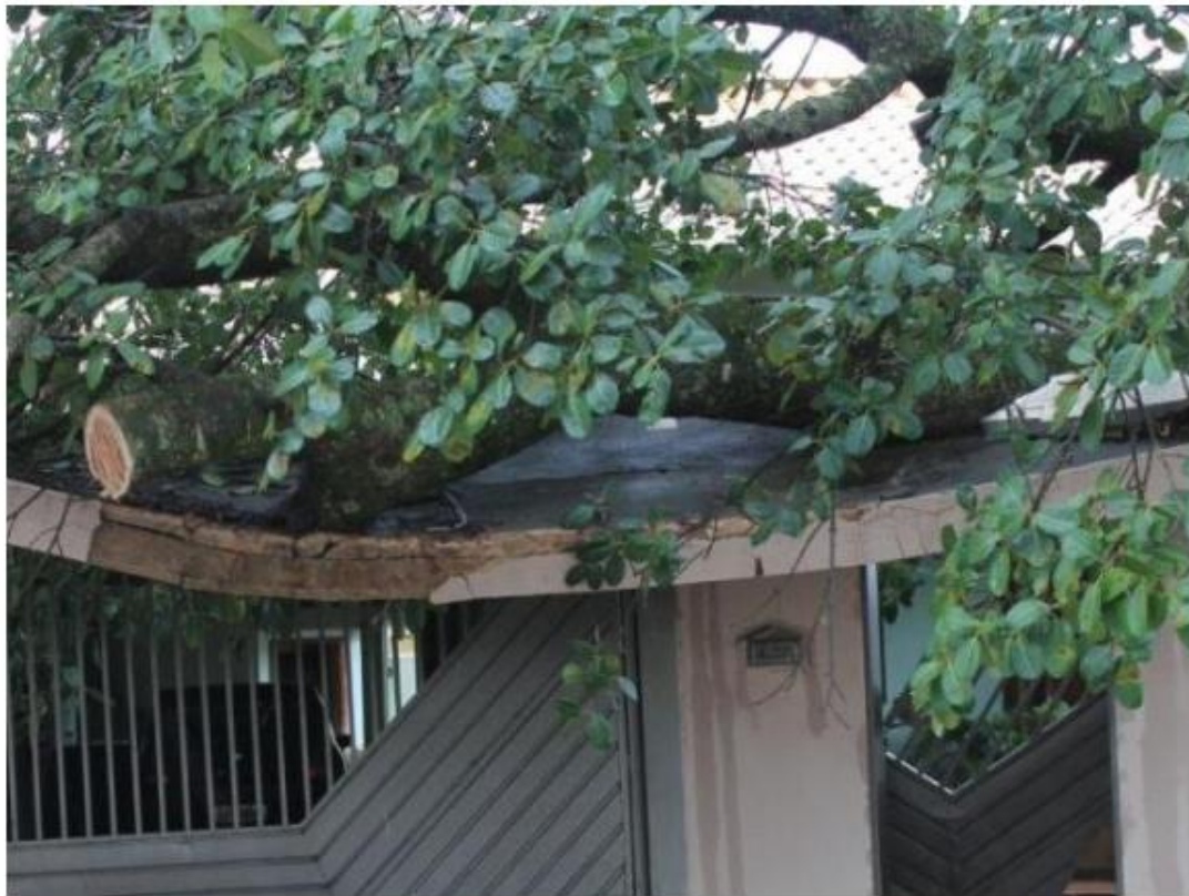
Árvore de aproximadamente 20 metros caiu sobre muro e marquise de portão (Foto: Marina Pacheco)
