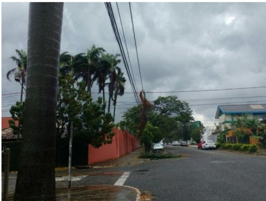
Galho em rede elétrica na Rua Alagoas (Foto: Amanda Bogo)
