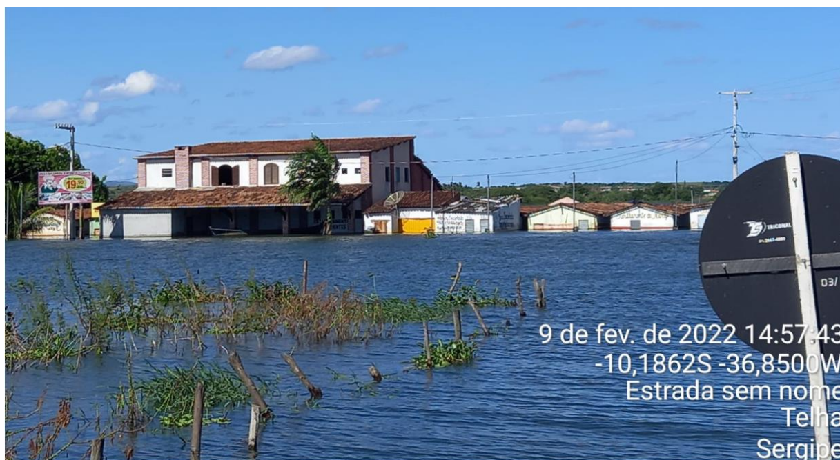
Inundação - Unidades consumidoras parcialmente submersas (Fonte: Energisa)
