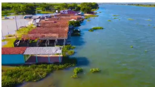
Região de bares do município de Telha ficou alagada — Foto: Prefeitura de Telha
