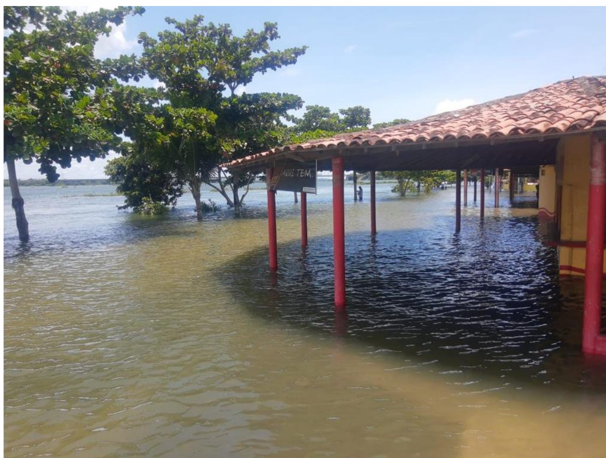
Inundação - Unidades consumidoras parcialmente submersas (Fonte: Energisa)
