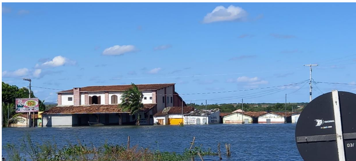
Inundação - Unidades consumidoras parcialmente submersas (Fonte: Energisa)
