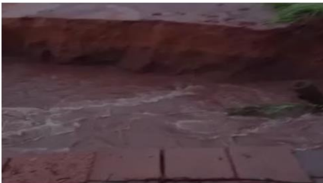
Pontes e estradas de acesso a comunidades foram destruídas durante chuvas em Vila Bela
