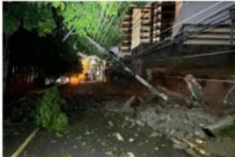
Queda de muro derrubou postes de energia no Poção, em Cuiabá
