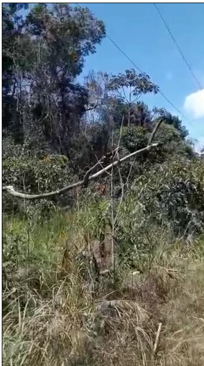
Arvore que estava fora da faixa caiu sobre a rede devido ventos fortes na região de Sorriso no dia 14/01/2022
