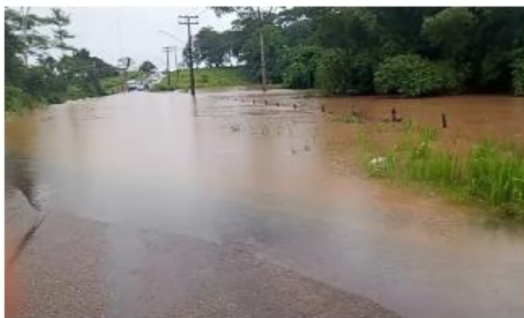
Igarapé transbordou e alagou estrada que dá acesso ao Complexo Penitenciário de Rio Branco — Foto: Galdemar Bomfim/Arquivo pessoal
