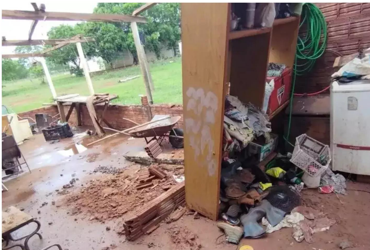
Casa de assentados foi destelhada pela força dos ventos em Bataguassu (Foto: Divulgação/Jornal Cidade MS)
