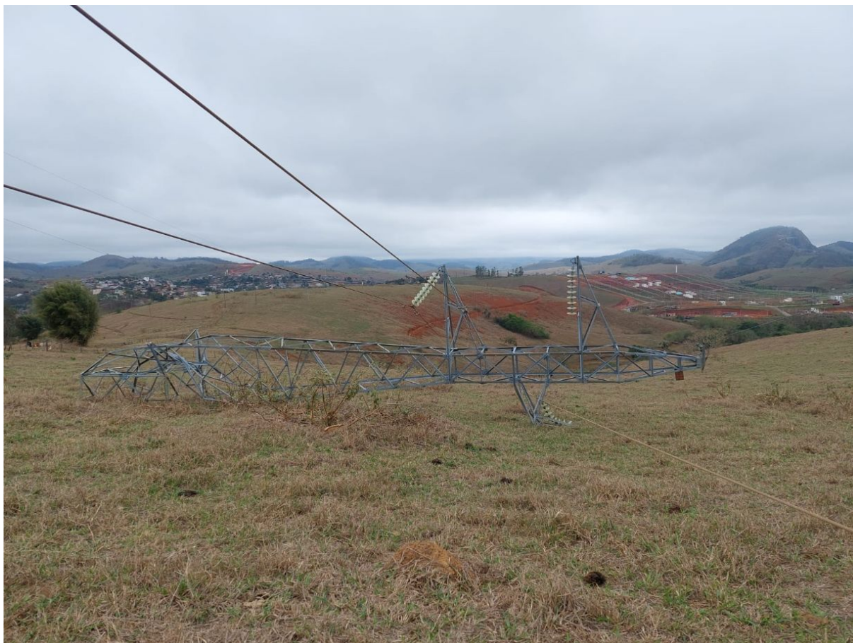
Foto registrada por colaborador da Energisa, estrutura da LDAT 138 kV UBR/MRE2. 06/10/2022.
