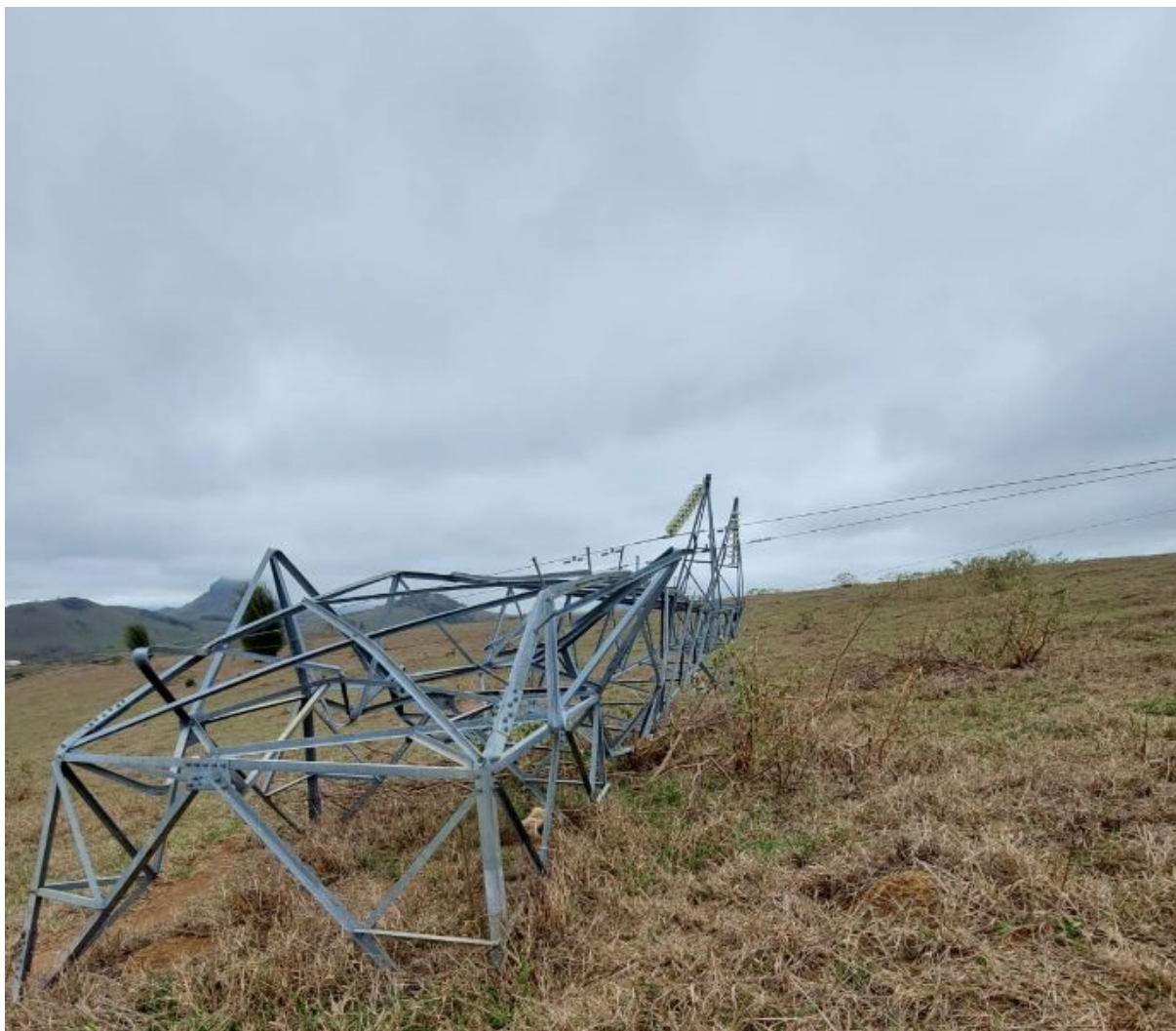
Foto registrada por colaborador da Energisa, estrutura da LDAT 138 kV UBR/MRE2. 06/10/2022.
