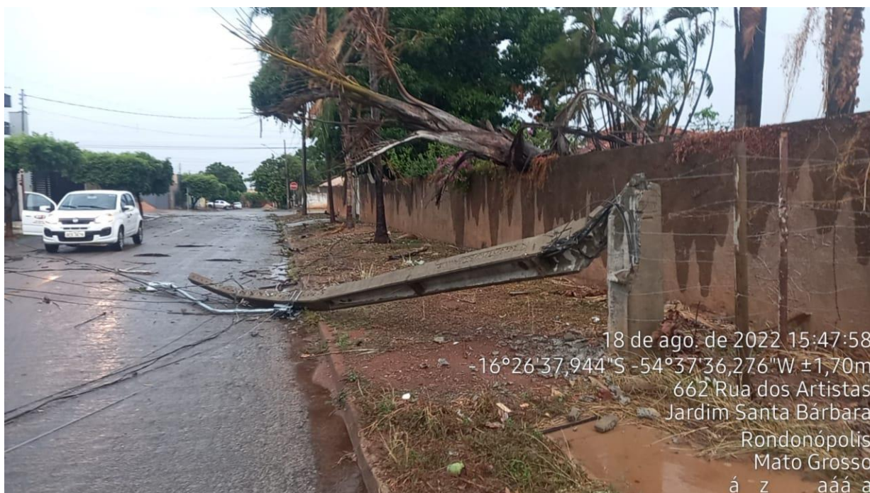
Figura 105 - Poste caído na rua em Rondonópolis - MT. Foto tirada em 18/08/2022
