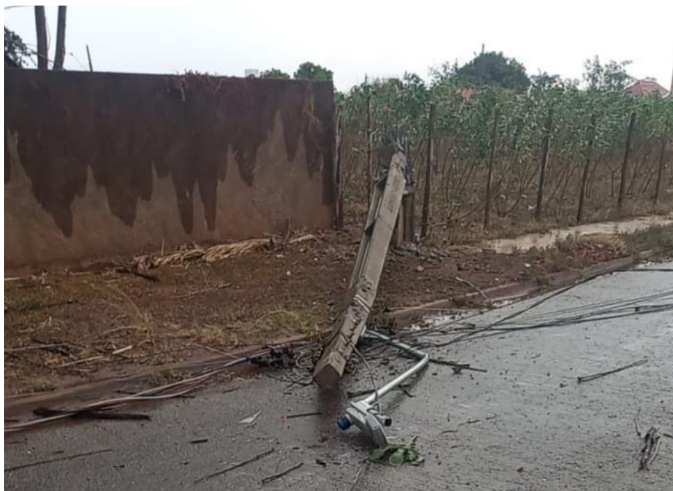
Figura 108 - Poste caído na Avenida dos Apóstolos - Jardim Riviera - Rondonópolis - MT. Foto tirada em 18/08/2022
