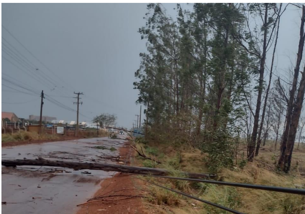
Figura 109 - Árvores caídas sobre a rede de distribuição em Rondonópolis - MT. Foto tirada em 18/08/2022
