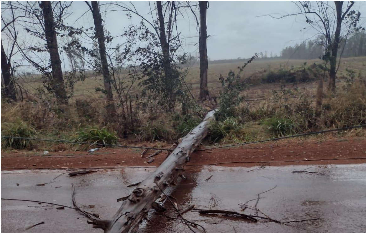
Figura 106 - Árvore caída sobre a rede de distribuição em Rondonópolis - MT. Foto tirada em 18/08/2022
