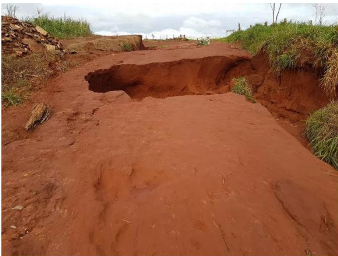
☐ Forte chuva dos últimos dias deixou estragos e causou transtornos aos moradores da zona rural de Novo Horizonte do Sul, MS (Foto: Prefeitura de Novo Horizonte do Sul/Divulgação)
