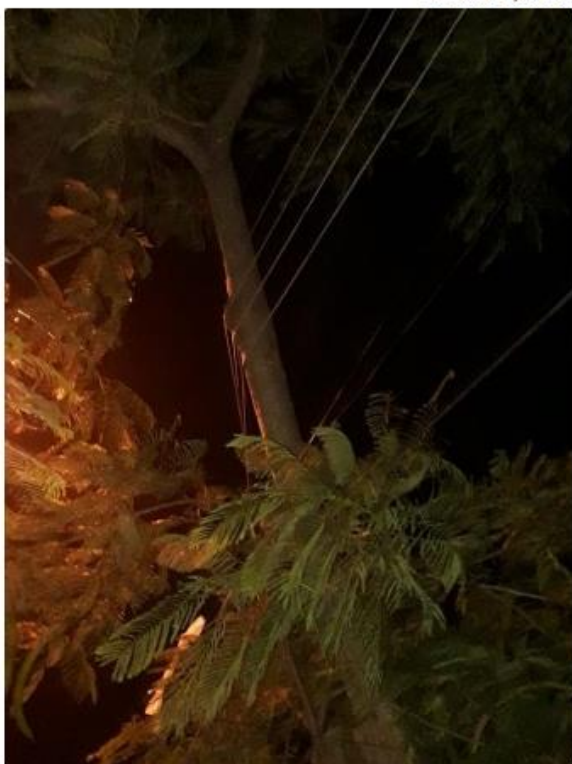
Árvore que tombou com a força do vento e ficou presa aos fios de alta tensão
