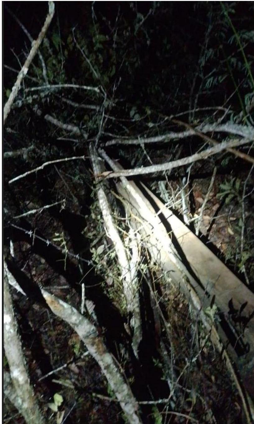
Ativos ao solo devido quedas de árvores (Fonte: Equipe Energisa)
