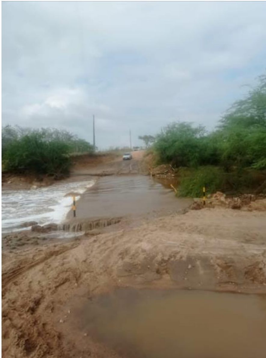
Alagamento - Localidade ilhada (Fonte: Equipe Energisa)
