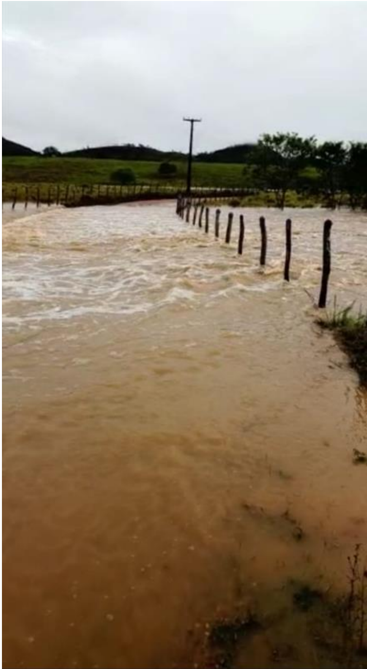
Alagamento - Estrada submersa por riacho (Fonte: Equipe Energisa)
