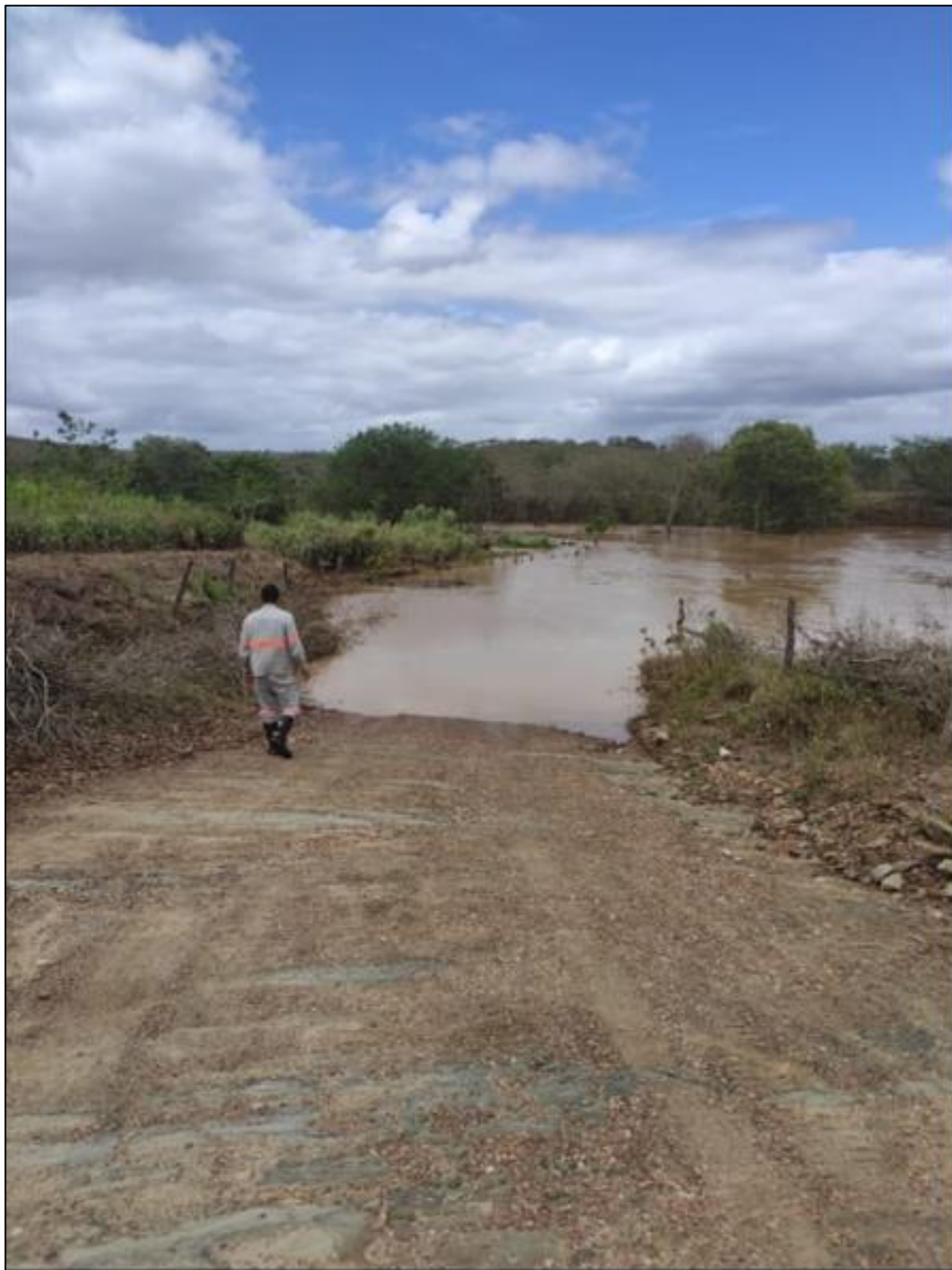
Alagamento - Estrada submersa por riacho (Fonte: Equipe Energisa)
