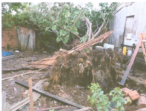
Temporal causou estragos em casa da Rua São Paulo, bairro Montanhês — Foto: Anáclio pessoal
