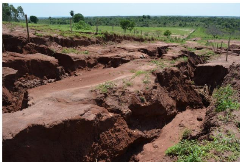
Travessão Tobogã, no Assentamento Foz do Rio Amambai. Crateras e erosão provocam interdição da estrada. Foto Roney Minella
