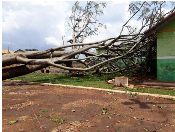
Árvore caiu em cima de escola em Bandeirantes (Direto das Ruas)
