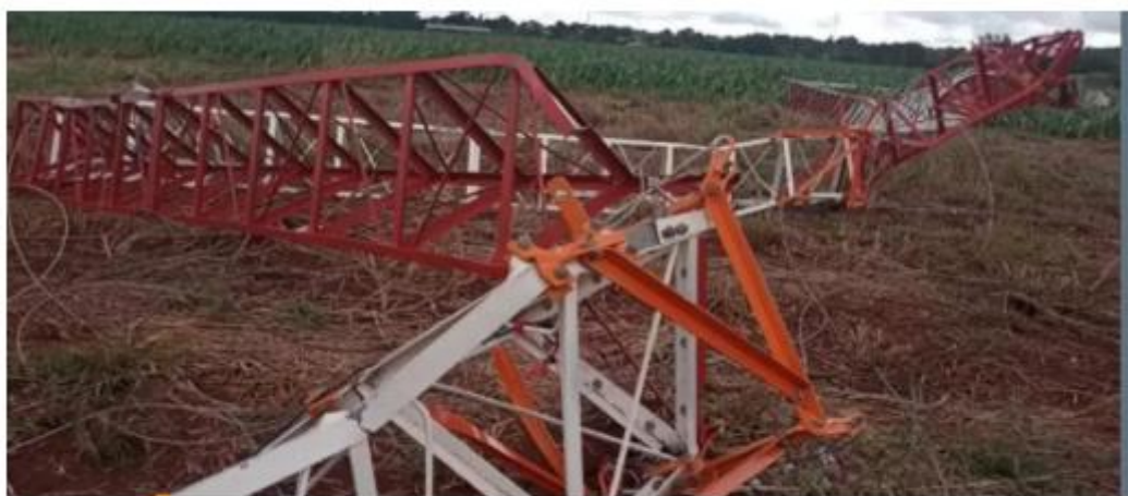
Torre de rádio foi derrubada com a força da chuva e dos ventos em Fátima do Sul (MS) — Foto: Leandro Santos
