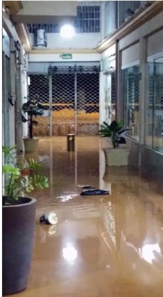
Água das chuvas entrou em prédios e galerias em Ubá — Foto: Joseph Rocha/Arquivo Pessoal
