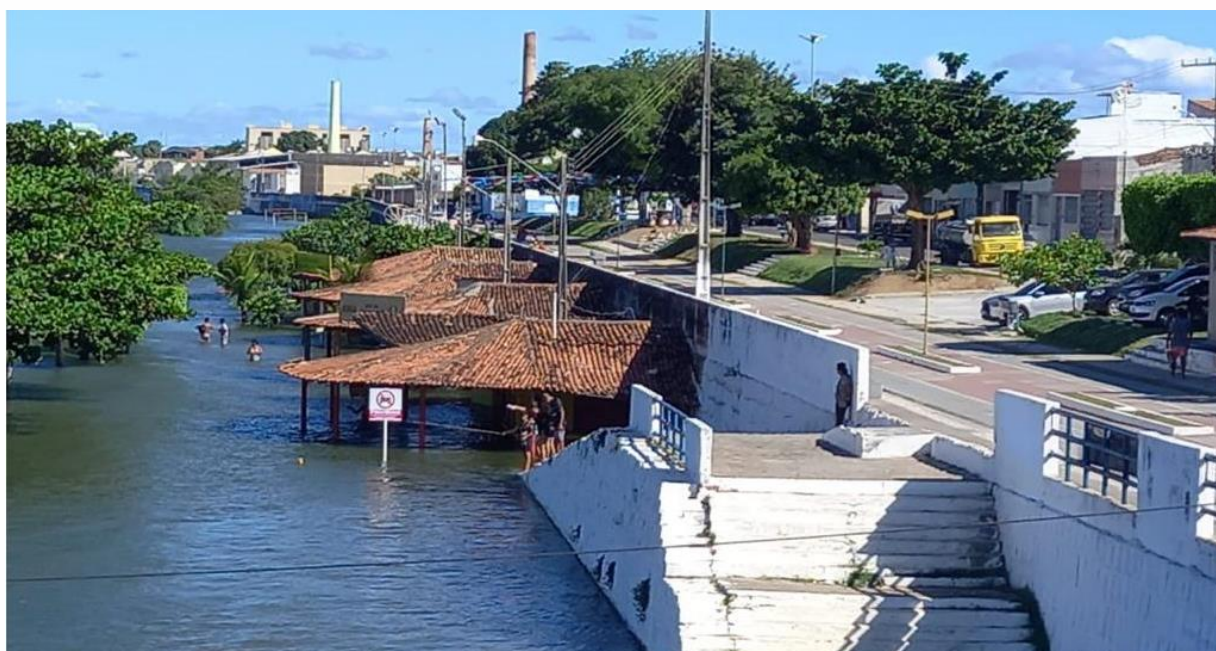
Inundação - Unidades consumidoras parcialmente submersas (Fonte: Energisa)
