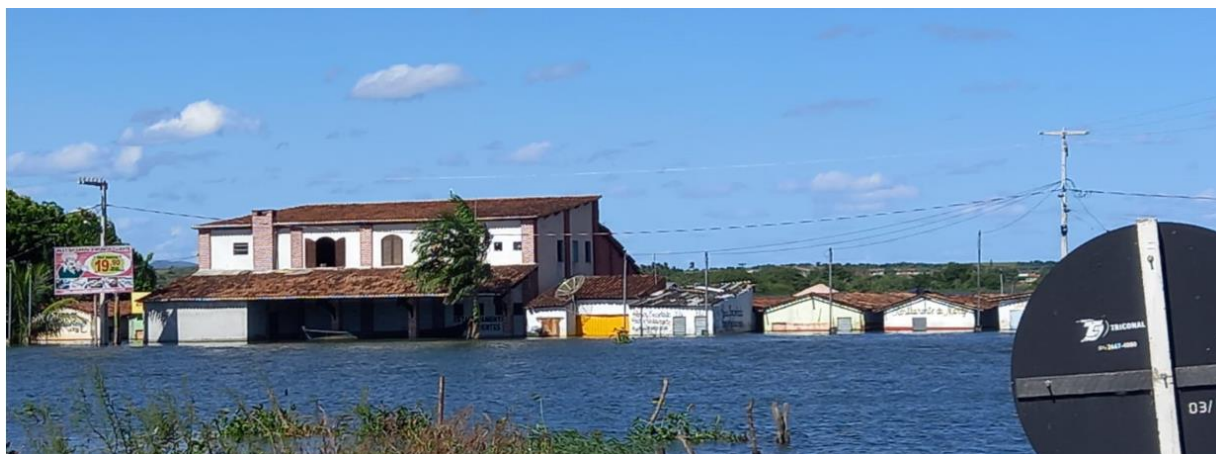
Inundação - Unidades consumidoras parcialmente submersas (Fonte: Energisa)
