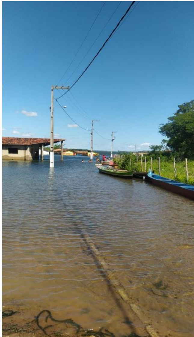
Inundação - Unidades consumidoras parcialmente submersas (Fonte: Energisa)
