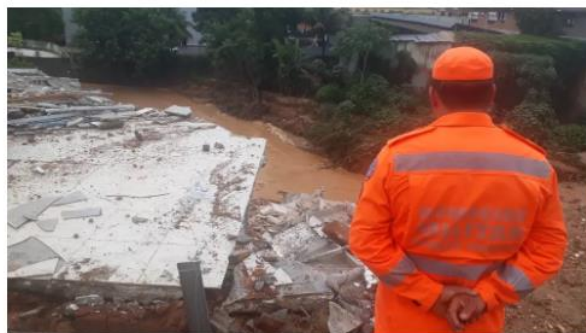
Prédio que estava interditado no Bairro Inês Groppo desmoronou após as chuvas em Ubá — Foto: Corpo de Bombeiros/Divulgação
