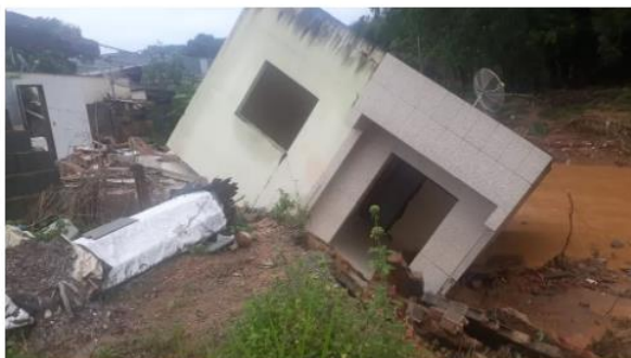
Casa caiu dentro do rio após chuva em Ubá — Foto: Corpo de Bombeiros/Divulgação
