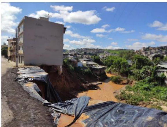
Prédio com risco de desabamento em Ubá em janeiro; estrutura caiu nesta quinta-feira pela madrugada — Foto: Guilherme Bonissati/G1
