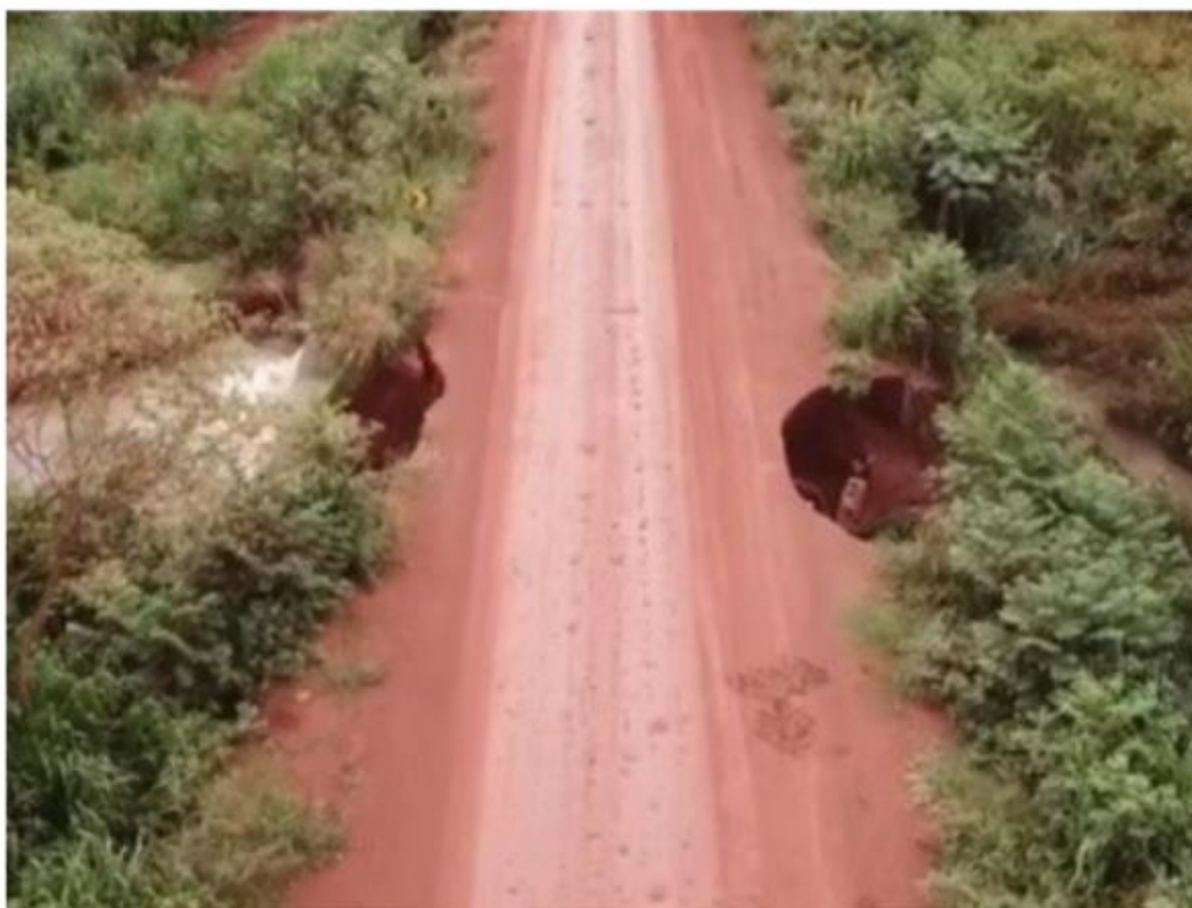
Solapamento da pista acontece dos dois lados. (Foto: Reprodução/Defesa Civil/Maracaju)
