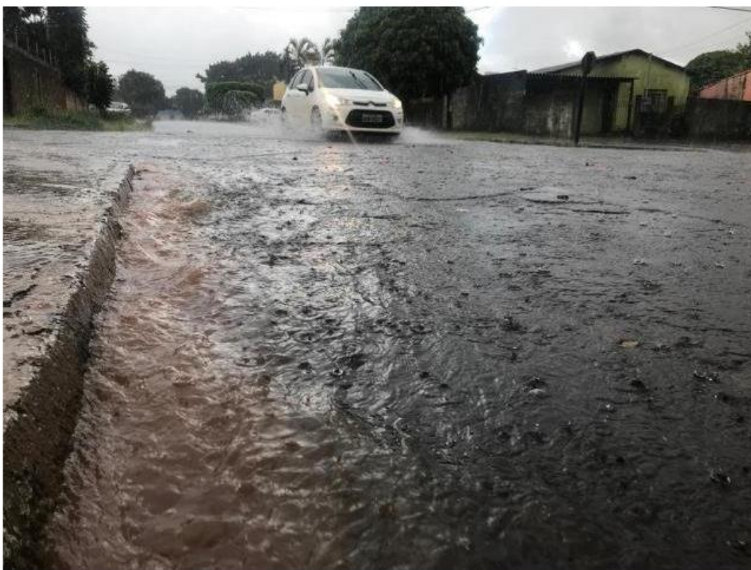
Na Rua das Hortências, chuva alagou parte da via, no Jockey Clube (Foto: Ronie Cruz)
