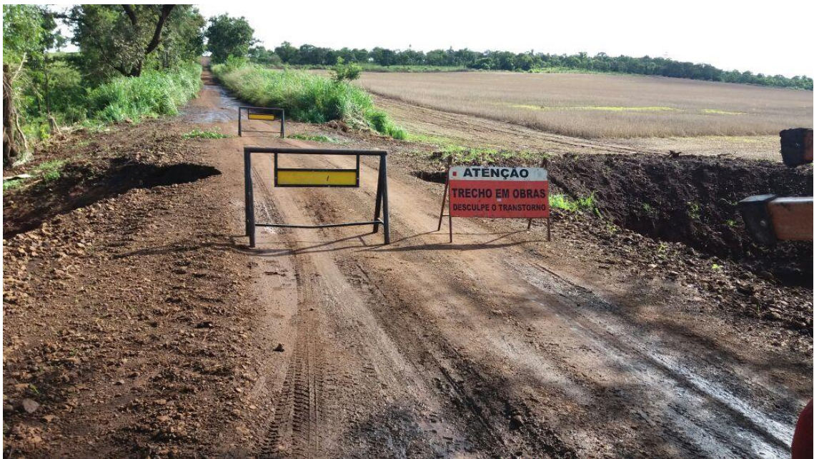
Foto de colaboradores da Energisa-MS: Bonito - março de 2018
