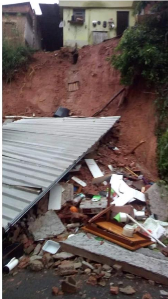
Casa deslizou e ficou destruída durante chuva em Cataguases — Foto: Prefeitura/Divulgação
