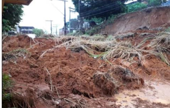
Em Muriaé, foram registrados deslizamentos e inundações — Foto: Defesa Civil/Divulgação
