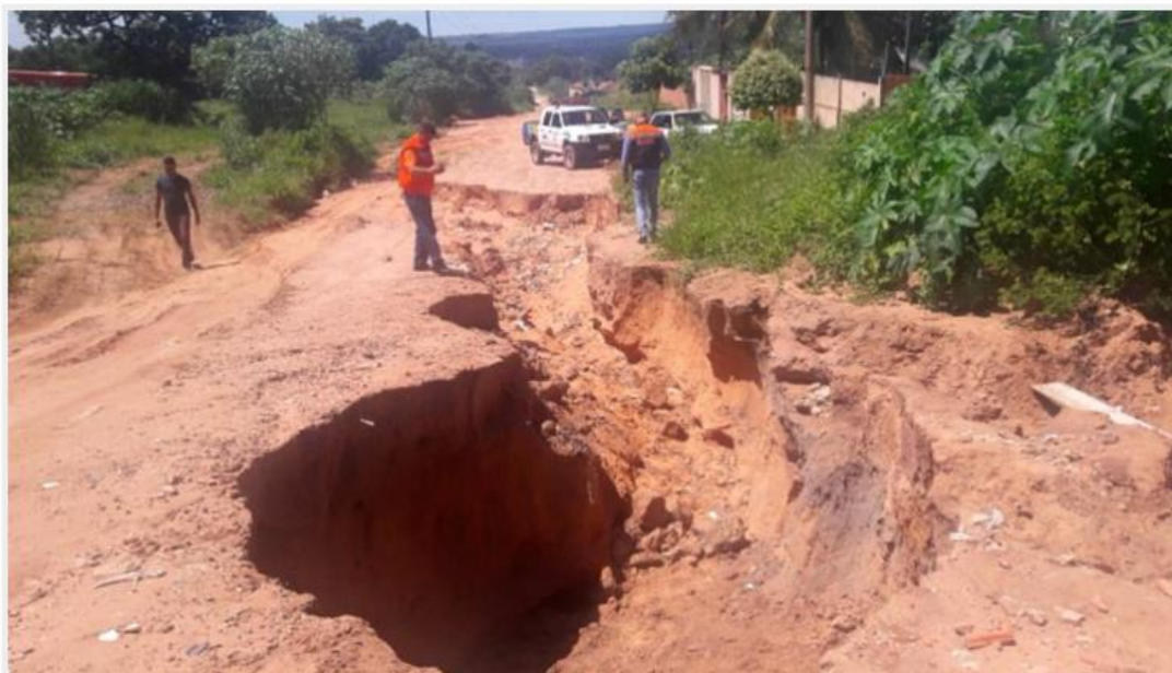
Governo de MS reconheceu nesta quarta a situação de emergência em Coxim e em outras quatro cidades, no município uma dos estragos foi voçoroca se abriu em rua paralela a BR-163 (Foto: Defesa Civil de MS/Divulgação)
