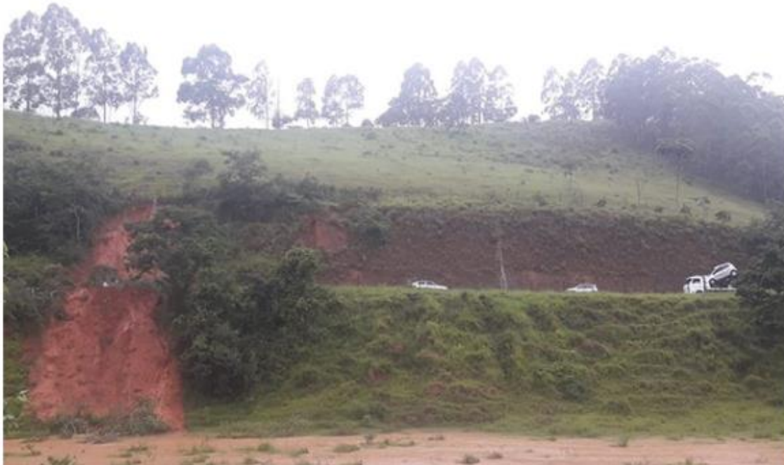
Deslizamento de terra na rodovia que liga Senhora de Oliveira a Lamin, causando a interrupção do trânsito neste trecho, ocorrida agora pouco e não confirmado.
