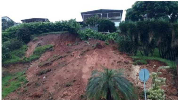
Deslizamento de terra em Guidoval (MG) — Foto: Corpo de Bombeiros/Divulgação
