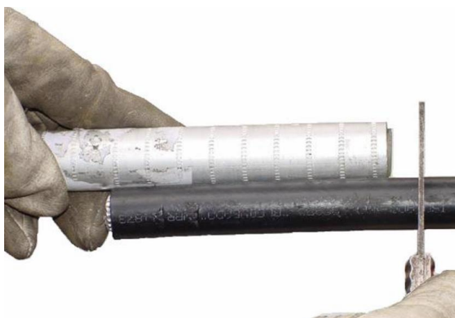
Figura I. Processo de decapagem e marcação do condutor.
