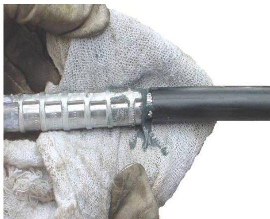
Figura II. Processo de decapagem e marcação do condutor.
