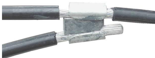
Figura IV. Processo de decapagem e marcação do condutor.
