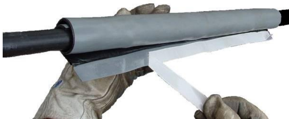
Figura IV. Processo de decapagem e marcação do condutor.
