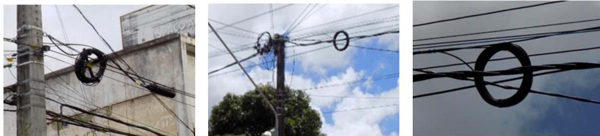
Figura 02. Instalações irregulares de reversas técnicas tipo cruzeta.
