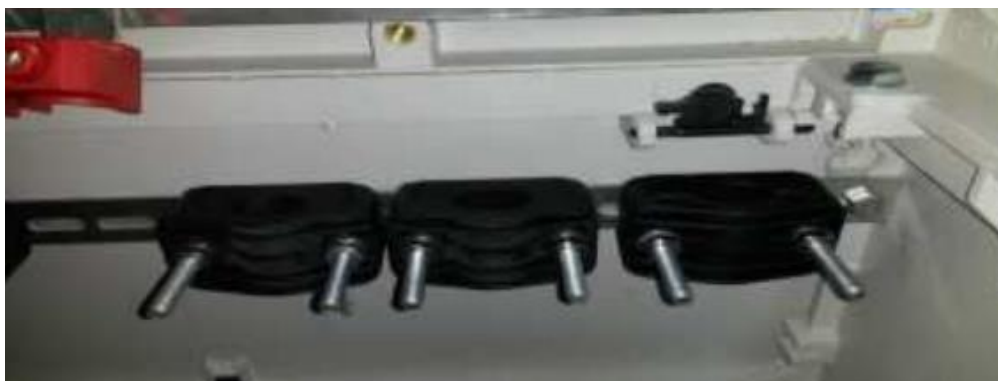
Foto 1 - Braçadeira para fixação dos cabos
